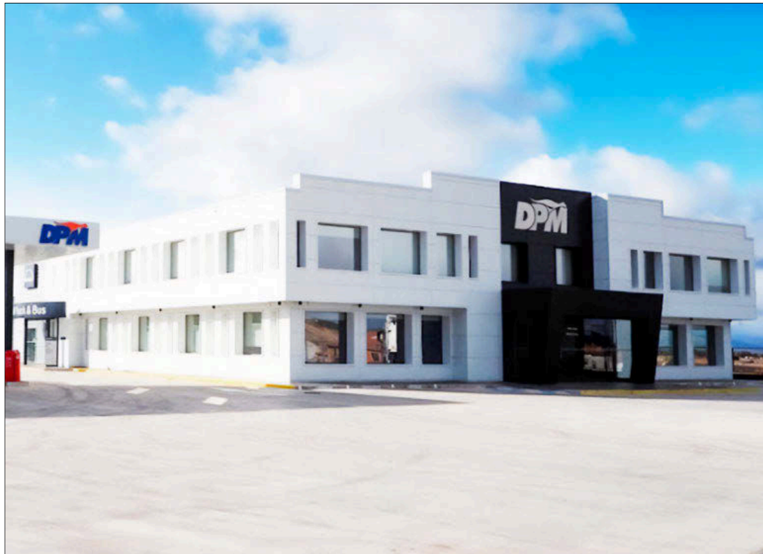
Instalaciones del Grupo DPM en el polígono industrial Las Casas. MARIO TEJEDOR
