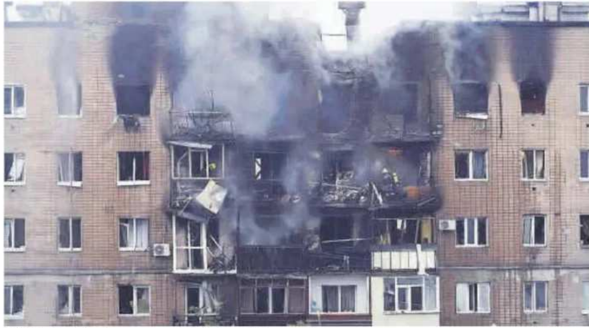
Edificio de viviendas gravemente dañado en Járkov por el ataque ruso.
