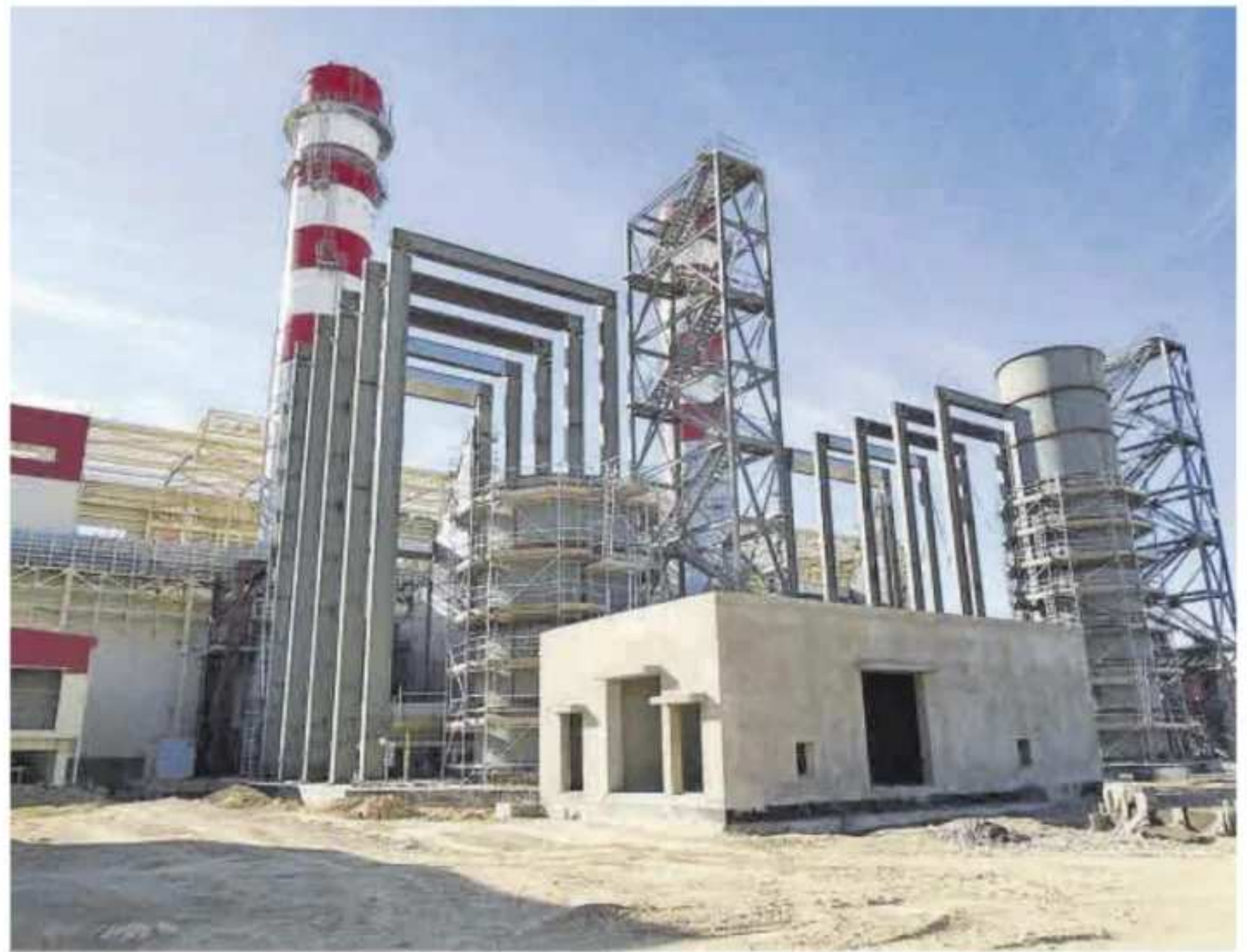
Central de ciclo combinado en construcción en Djelfa, Argelia, motivo del desencuentro entre Duro y Sonelgaz. | DF
