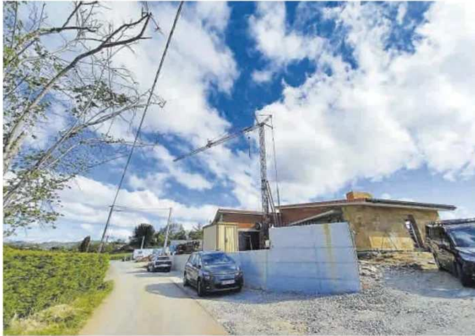
Viviendas en construcción en la zona de Tiñana. | P. T.
