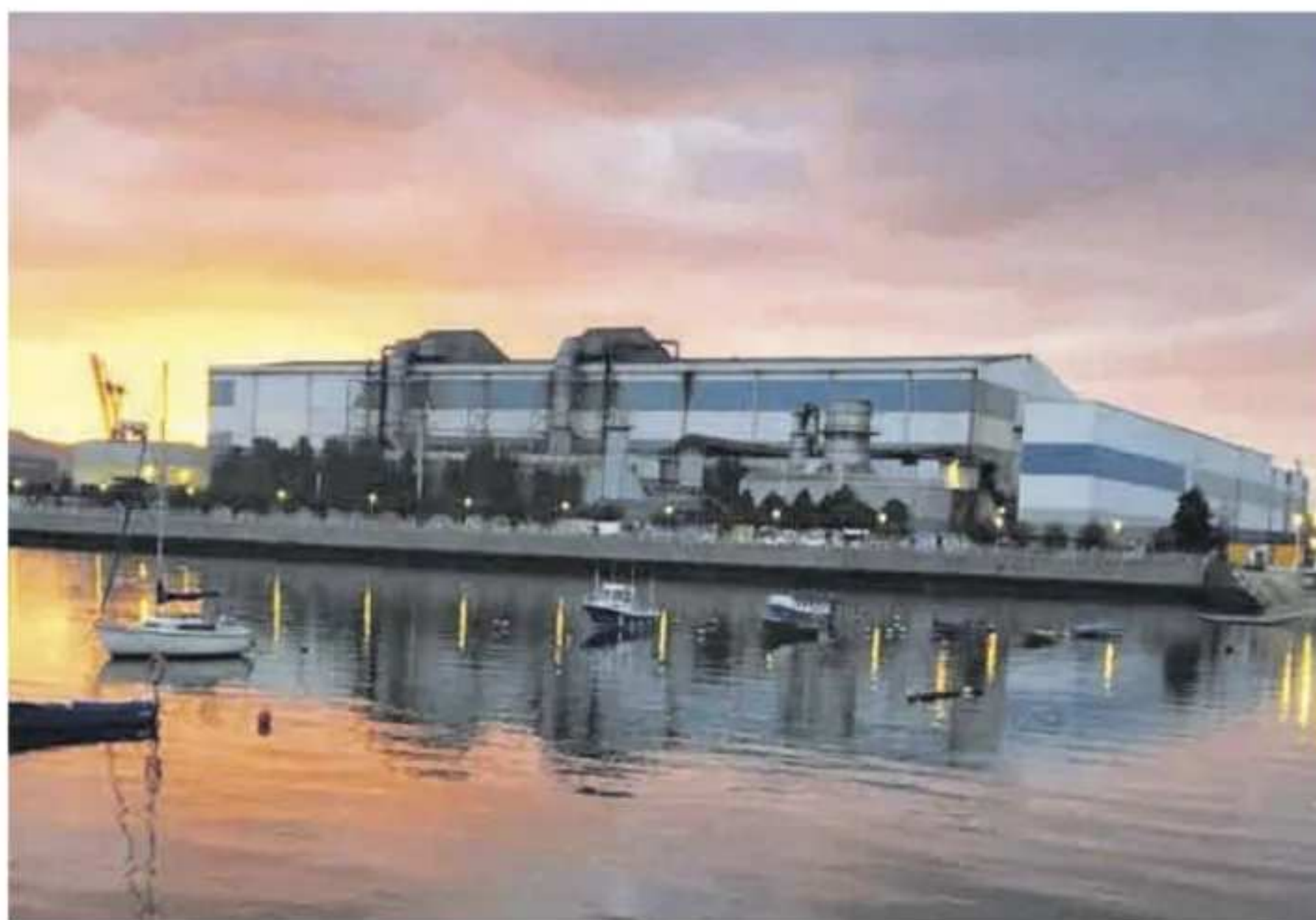
La acería compacta de Sestao (Vizcaya), propiedad de ArcelorMittal.
