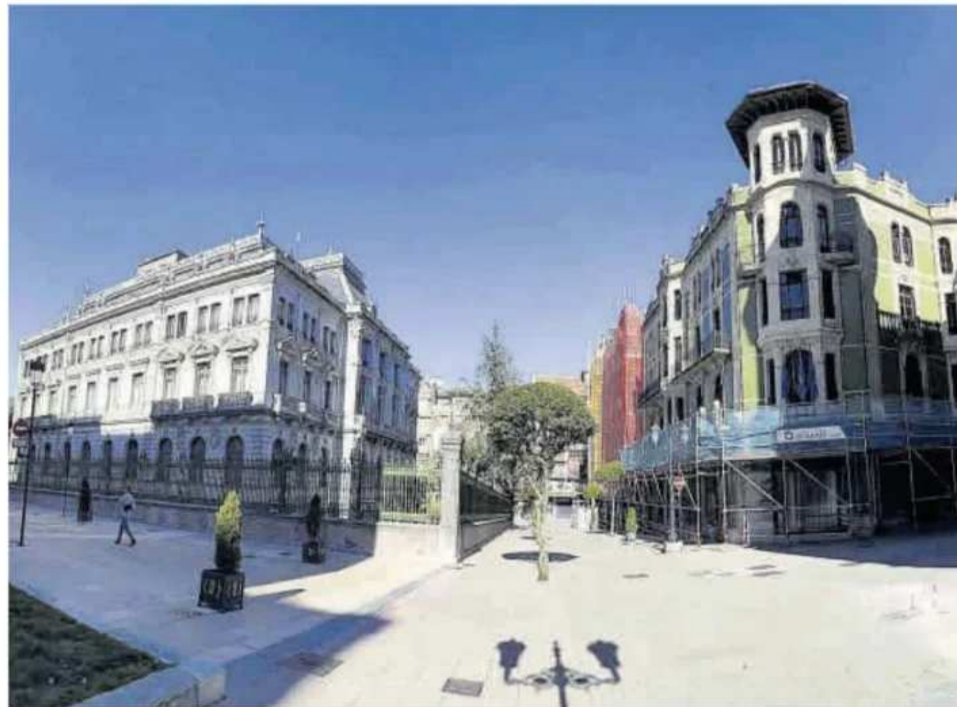
UN PASO SUBTERRÁNEO PARA UNIR DOS EDIFICIOS CENTENARIOS. A la derecha, el «edificio verde» que comprará el Principado para albergar dependencias de la Junta General, que puede verse a la izquierda. | Juan Plaza
