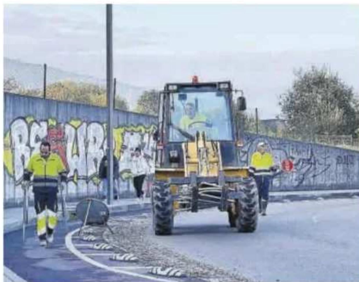
Los operarios, en el comienzo de las obras. | C. V.
