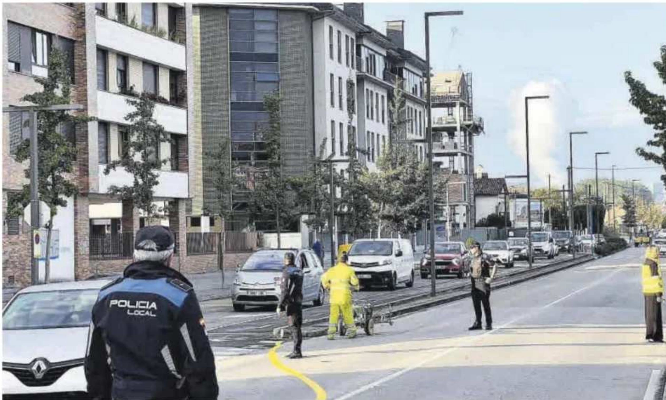
Trabajos de renovación urbana de la avenida de Oviedo, en Lugones. | Carla Vega
