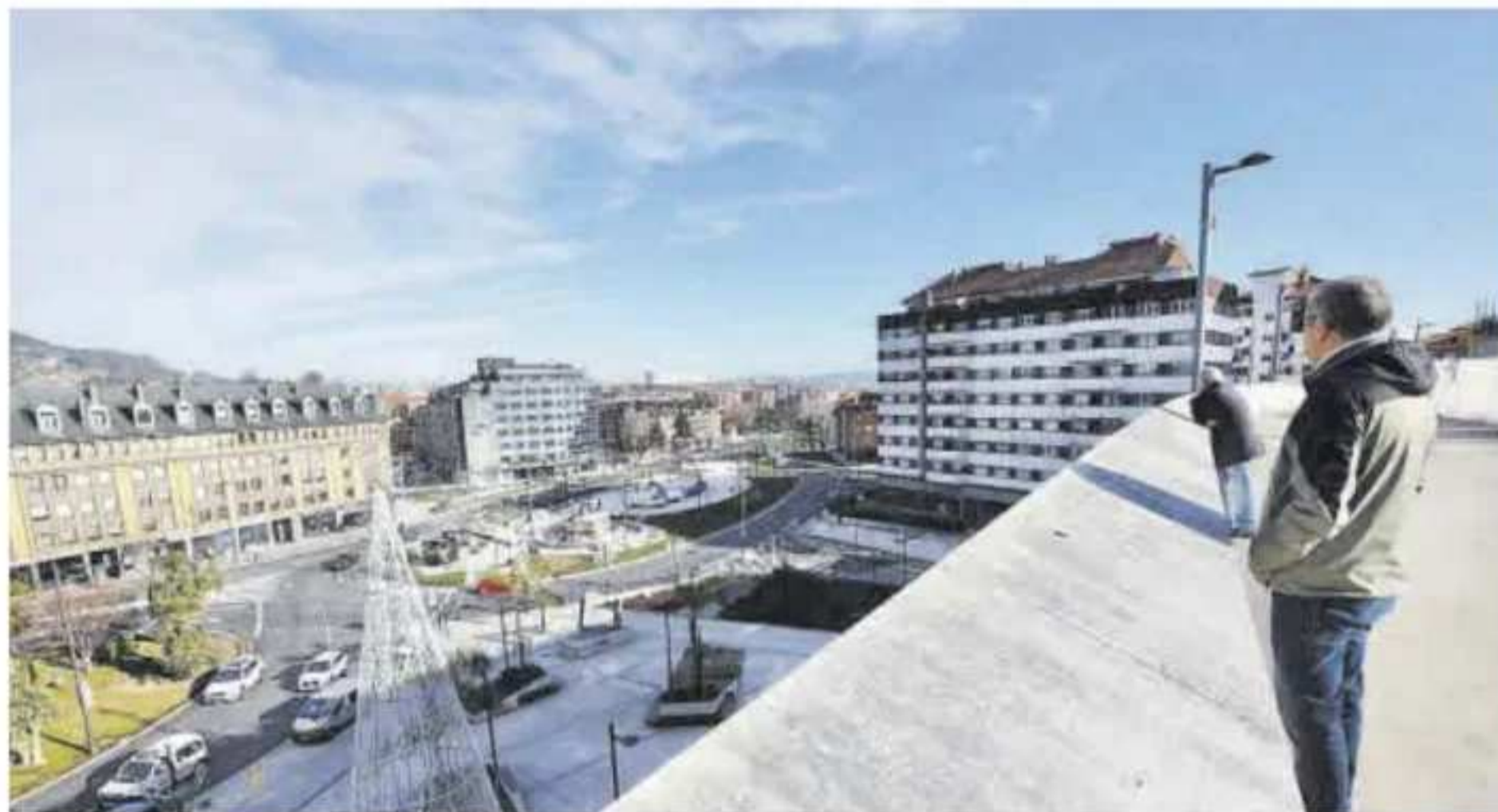
Paseantes observando el avance de las obras desde la parte alta del bulevar del Vasco. | Miki López
