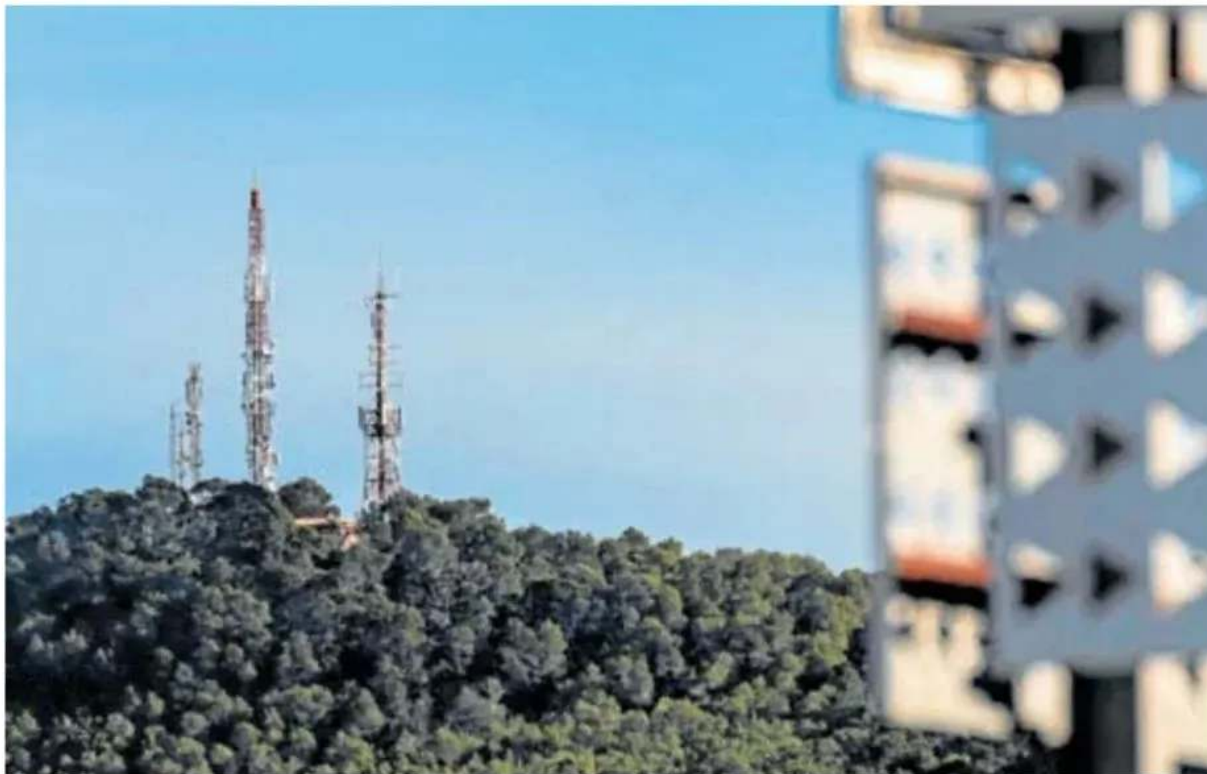
Una torre de telecomunicaciones en Palma. EFE
