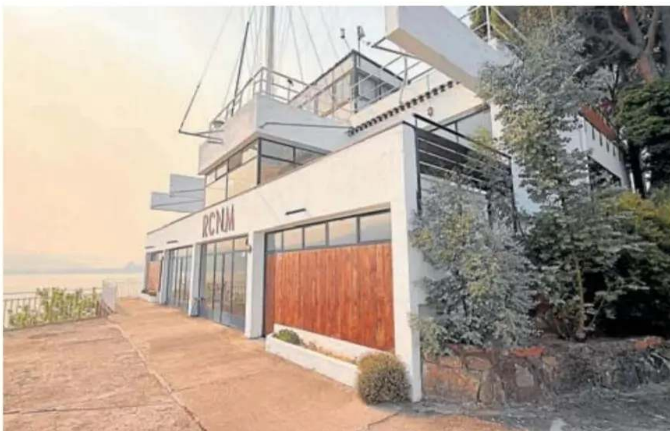
El edificio principal del Real Club Náutico de Madrid se salvó de las llamas. RCNM
