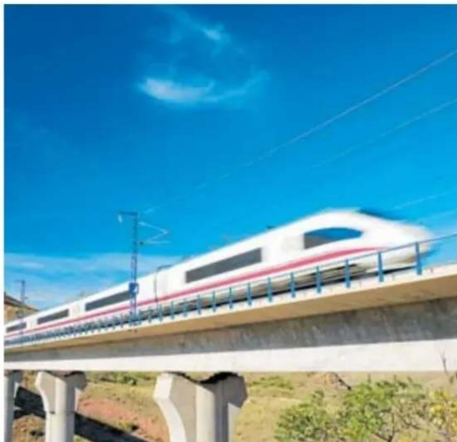
Paso de un tren de alta velocidad en el trayecto Madrid-Barcelona. ABC
