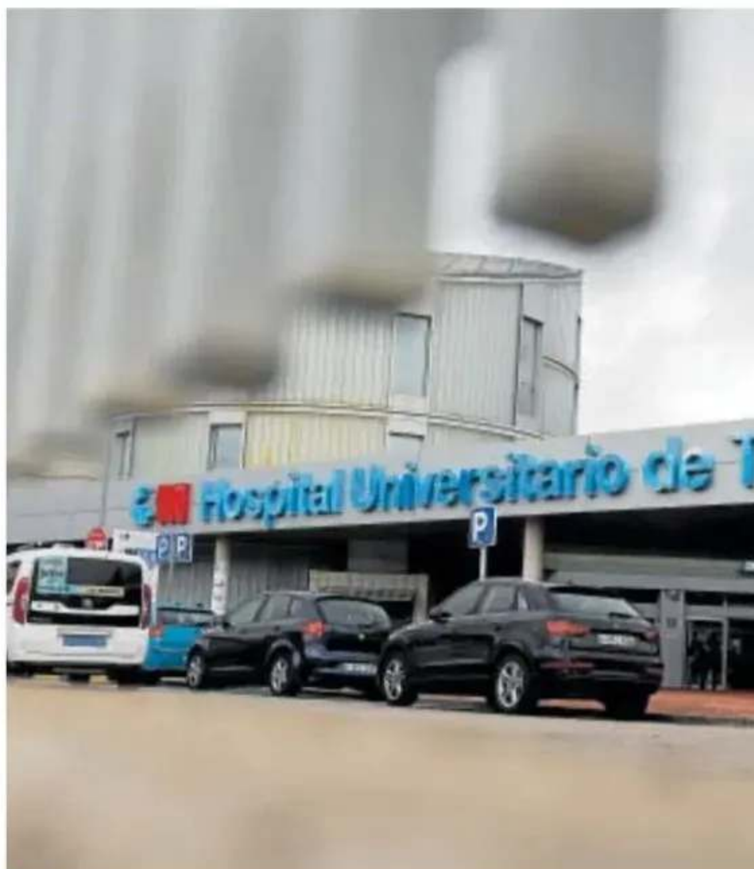
Vista de la entrada del Hospital de Torrejón de Ardoz // EFE
