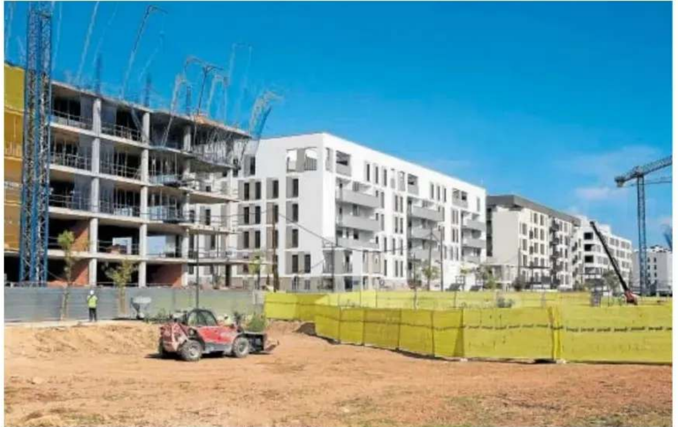
Varios edificios de viviendas en construcción en Madrid // JAIME GARCÍA
