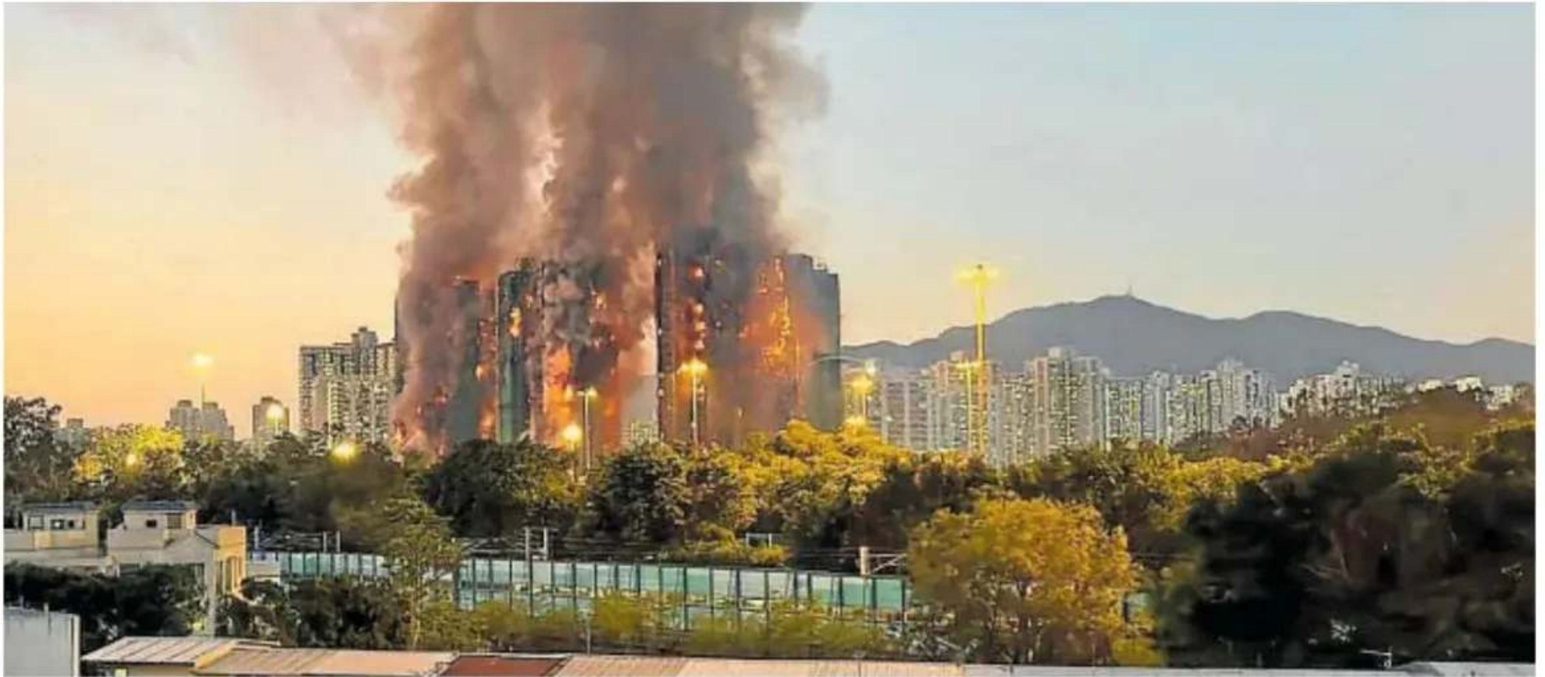
El fuego se propagó rápidamente por la urbanización Wang Fuk Court, en el distrito de Tai Po, que venía siendo reformada desde julio del año pasado // AFP
