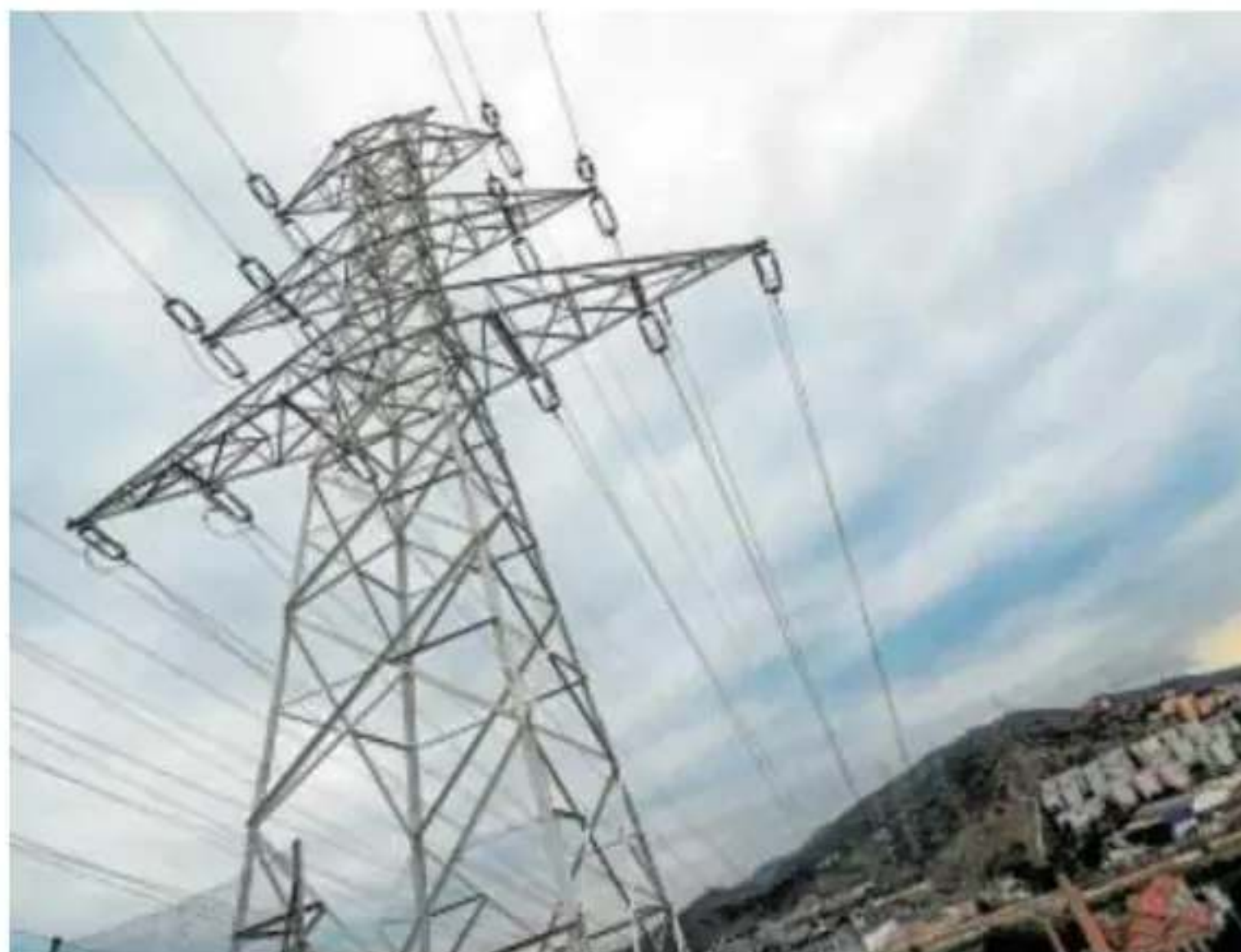
Una torre de tendido eléctrico // ABC
