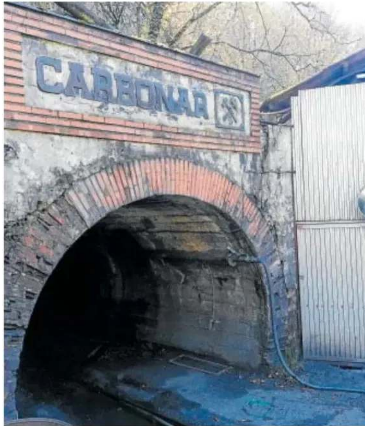
Mina de Carbonar en Vega de Rengos, donde se produjo el accidente // ABC
