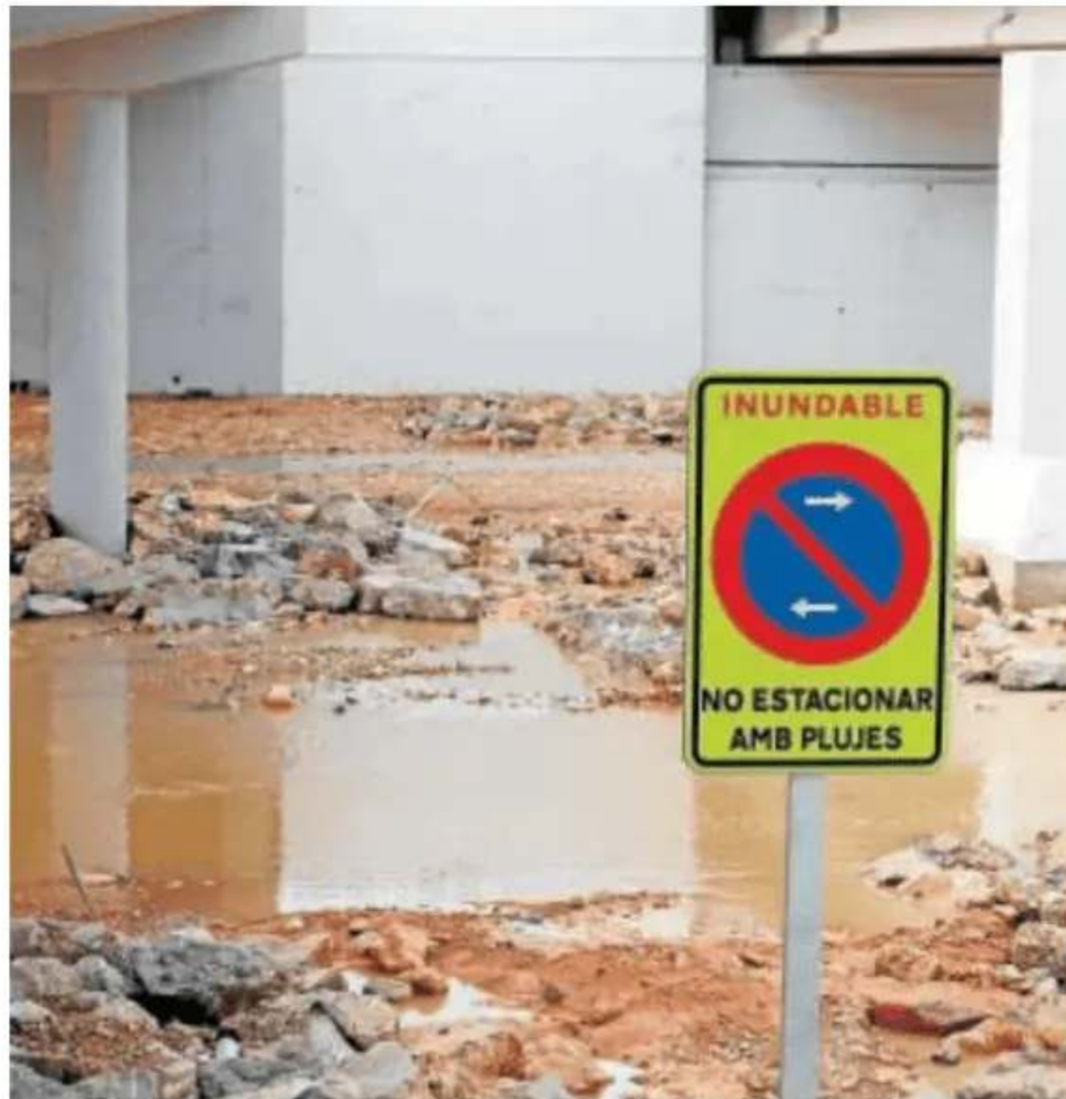
Obras en el barranco del Poyo, a su paso por Paiporta (Valencia) // JAIME GARCÍA
