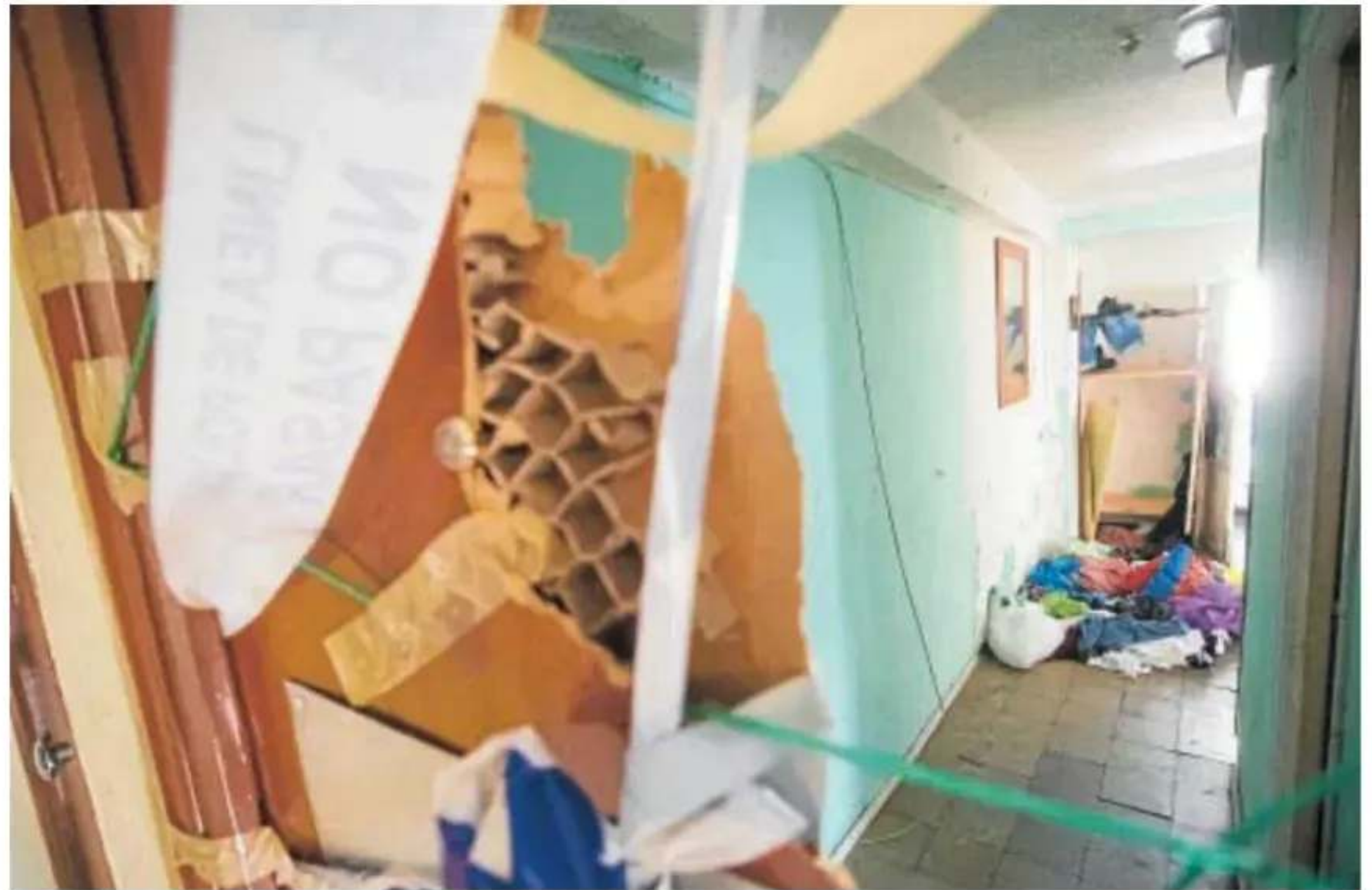
Una vivienda desalojada en Madrid tras haber sido okupada // DE SAN BERNARDO
