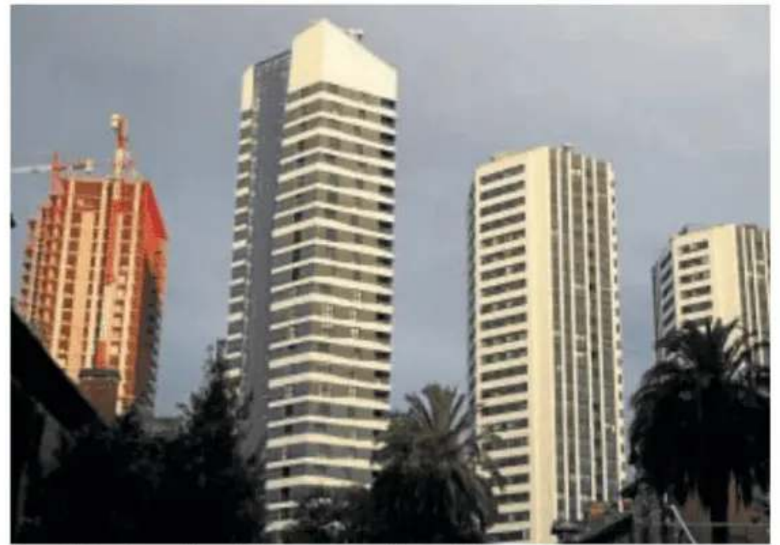
Una vivienda residencial en construcción en Bilbao // EFE
