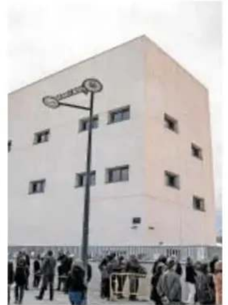
Hospital La Fe // MIKEL PONCE
