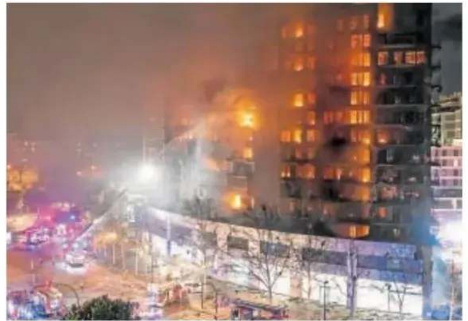
Imagen del incendio en el edificio de Valencia en febrero de 2024 // MIKEL PONCE
