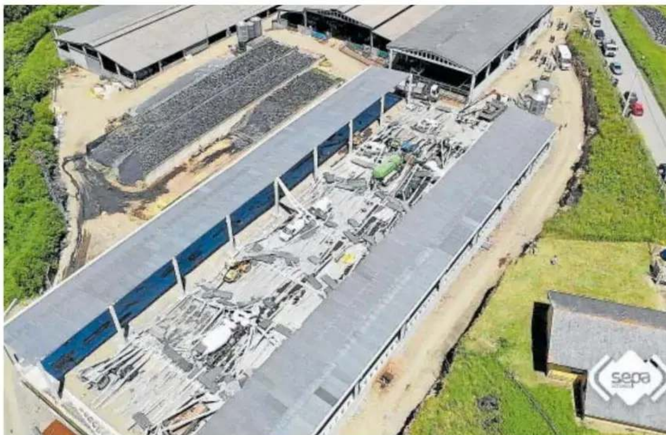
La nave ganadera de Coaña que colapsó ayer y atrapó a las tres personas fallecidas y las heridas // EFE
