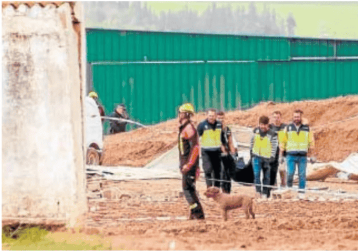
Búsqueda de personas en la nave derrumbada en Coria del Río (Sevilla) // EP
