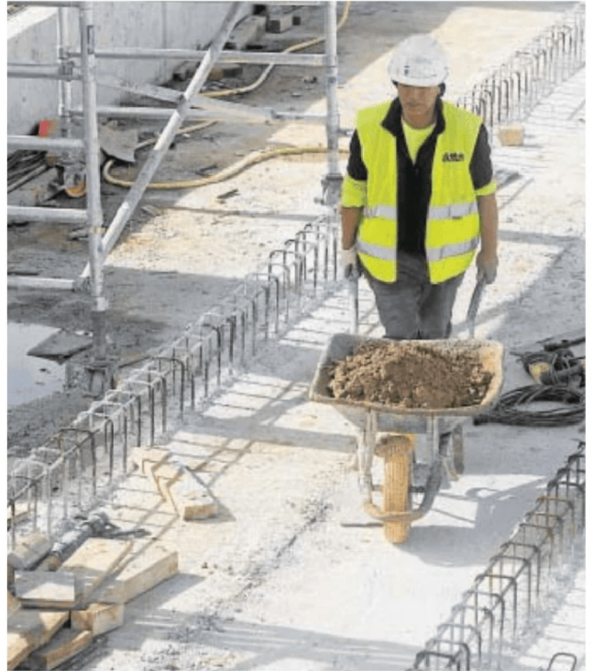
Un trabajador trabaja en la construcción de un inmueble // BELÉN DÍAZ
