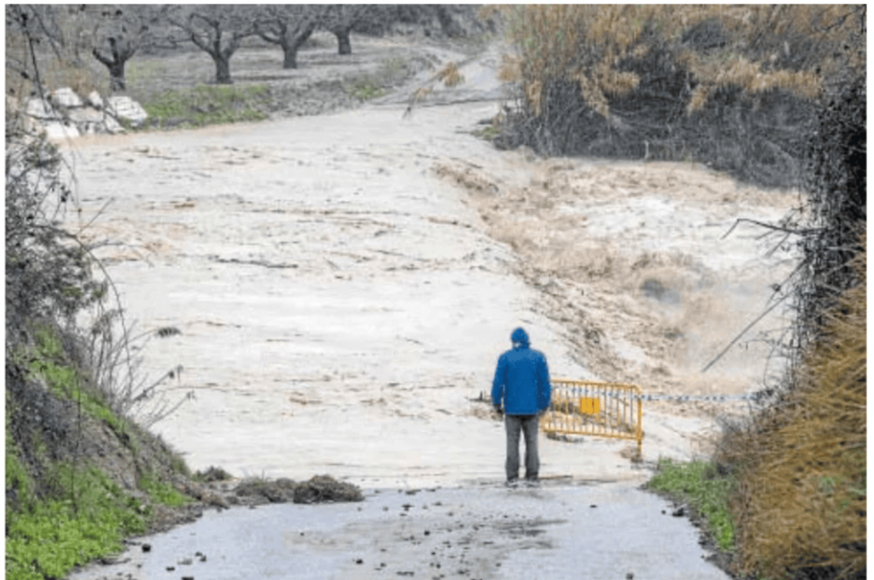
Desbordamiento en la carretera que une el municipio de Cehegín, (Murcia) con Canara // EFE
