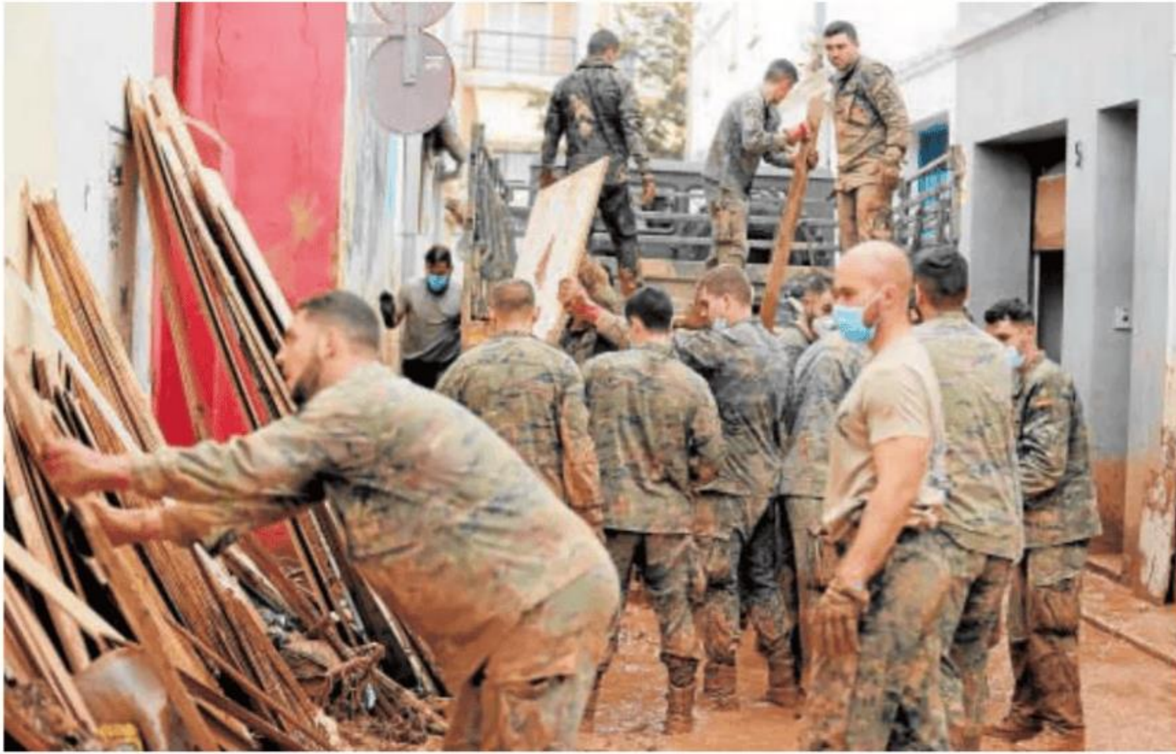
Militares trabajan en tareas de limpieza y desescombro en uno de los lugares azotados por la DANA // JAIME GARCÍA
