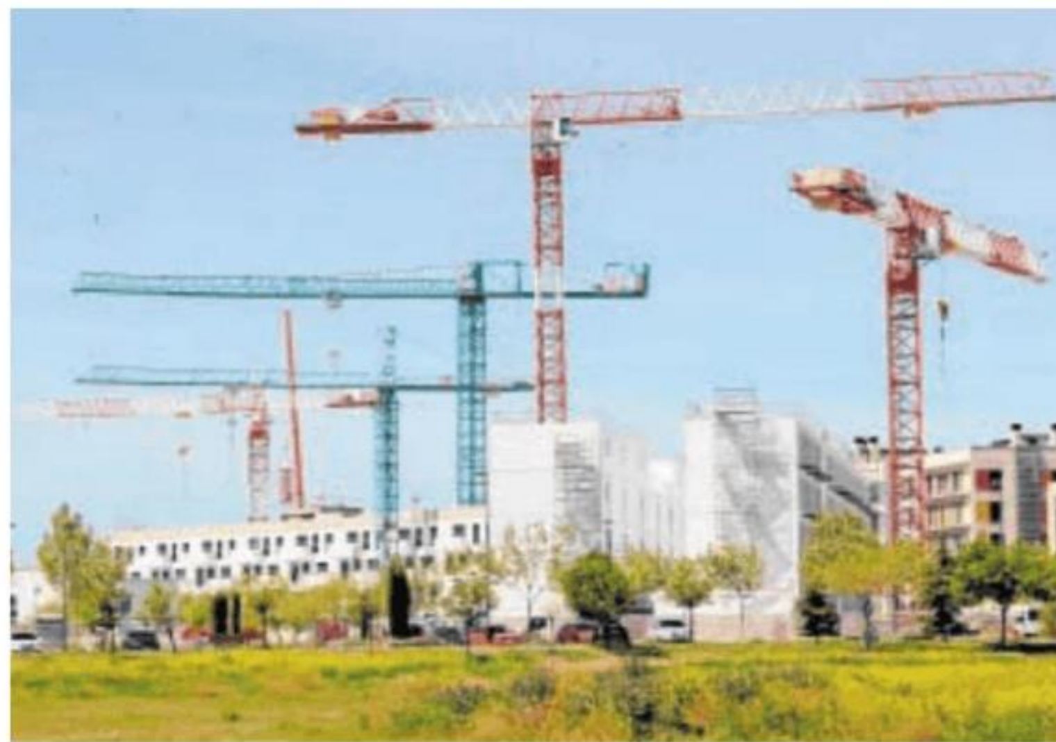
Edificios de pisos en construcción // JAIME GARCÍA
