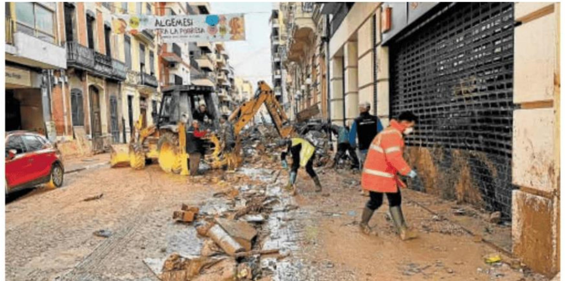
Las calles de Algemesí están llenas de escombros por la riada y de voluntarios que los retiran // PABLO M. DÍEZ
