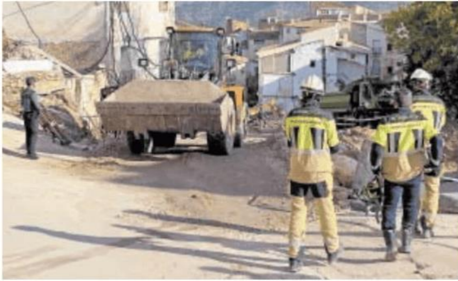
Los equipos de emergencia, trabajando en una de las calles de Letur // EFE
