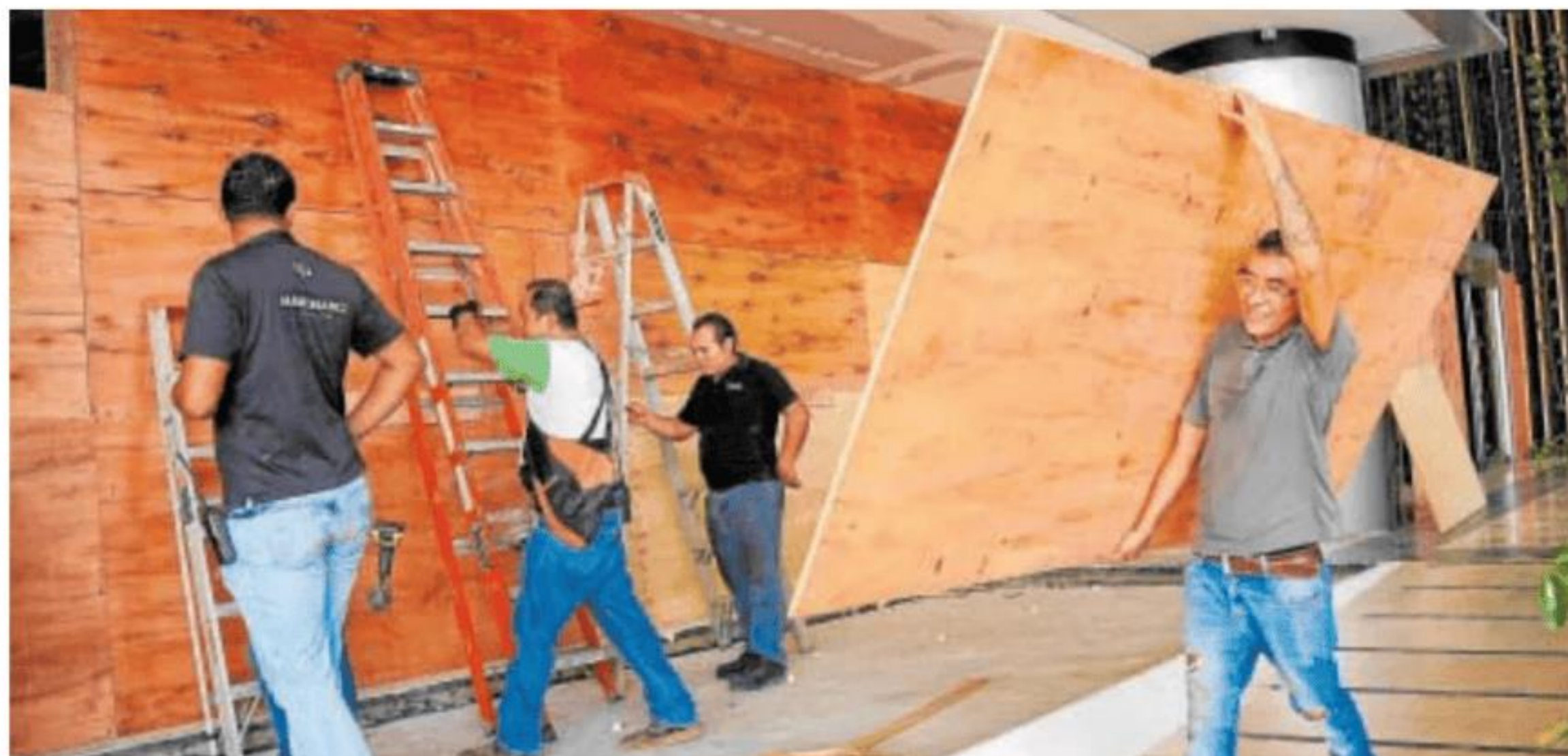
Varios operarios instalan láminas de madera para proteger locales de la tormenta Milton // AFP
