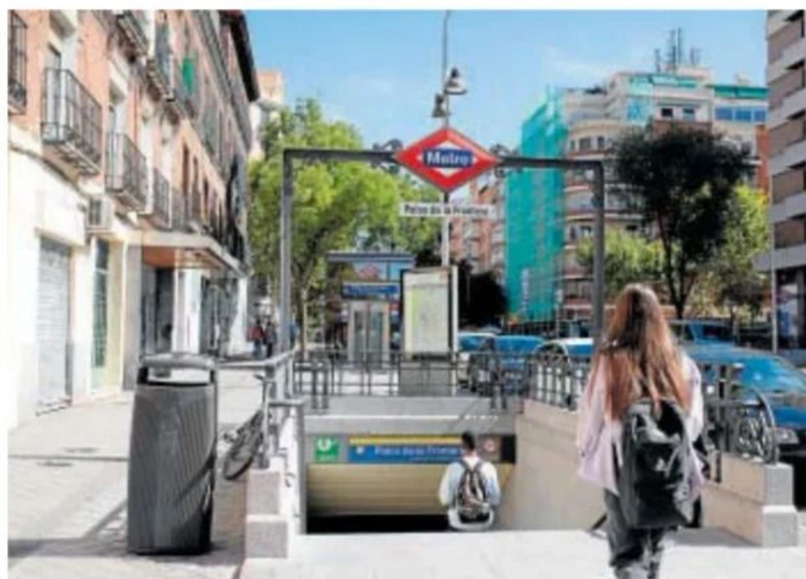
La parada de Metro de Palos de la Frontera que será reformada // ISABEL PERMUY
