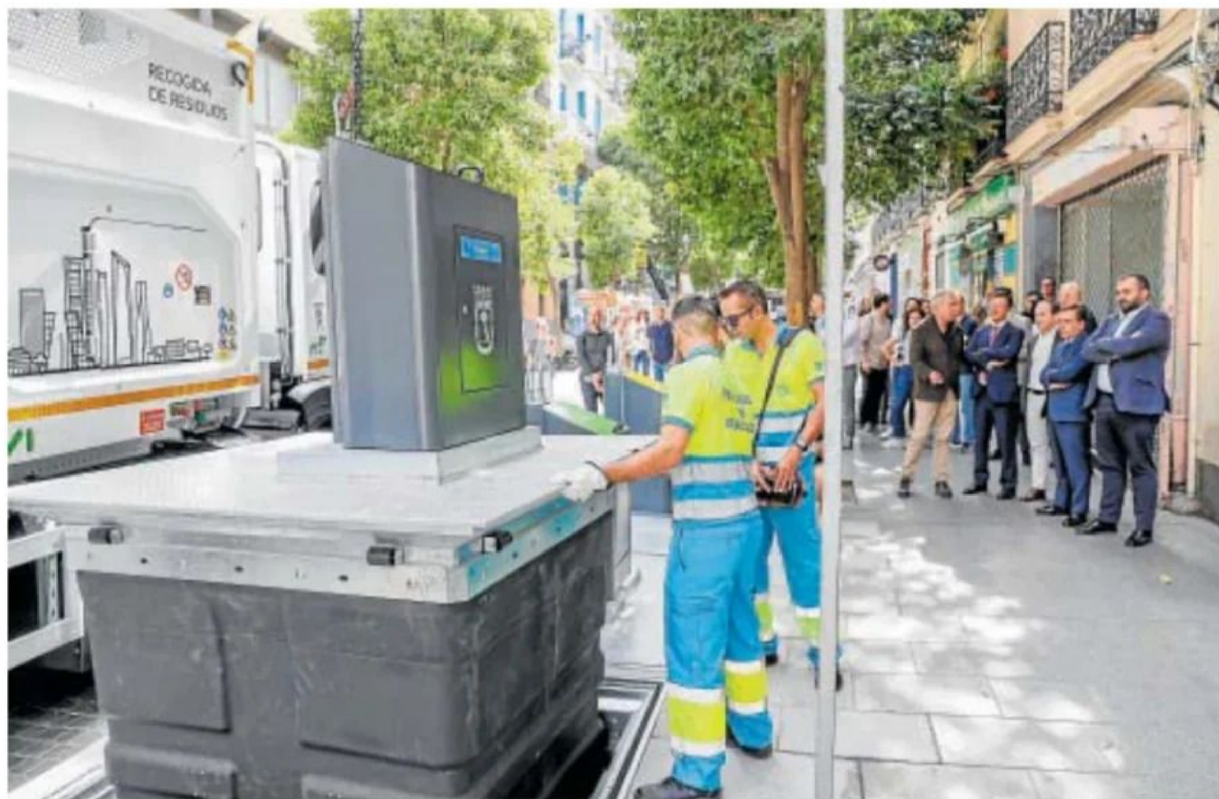
Los nuevos contenedores soterrados en la calle de Manuela Malasaña, 9 // AYUNTAMIENTO DE MADRID
