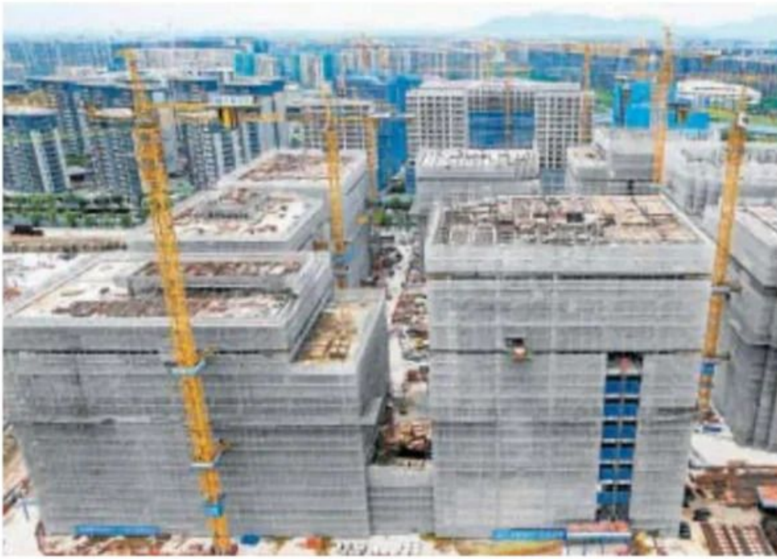
Construcción de edificios de vivienda en Hangzhou, al este de China // AFP
