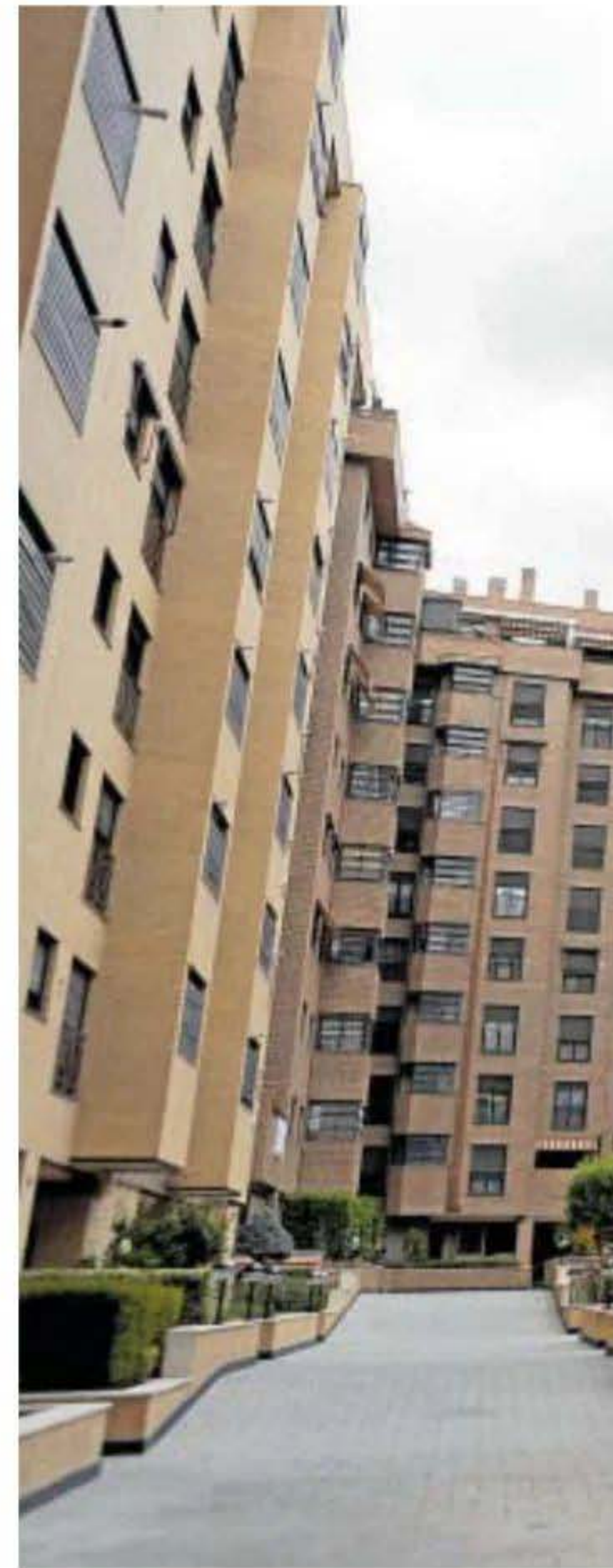
Interior de la urbanización afectada, en la calle de El Yesero // ISABEL PERMUY
