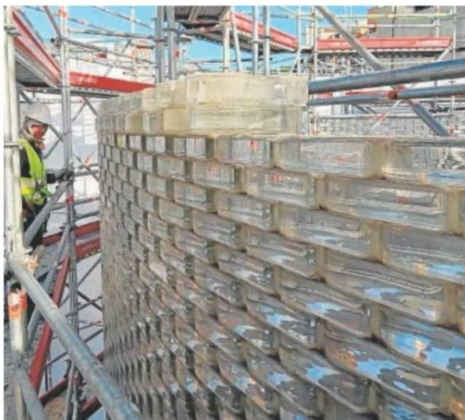
Desmontaje, uno a uno, de los ladrillos de vidrio del monumento // ABC
