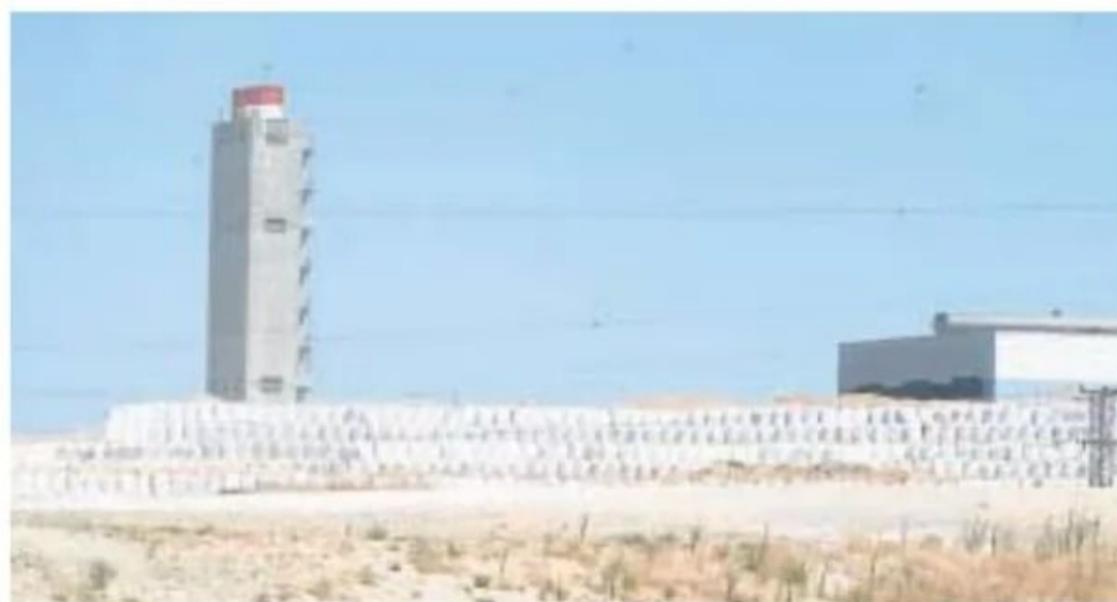
La planta de tratamiento de residuos de Valdemingómez // DE SAN BERNARDO
