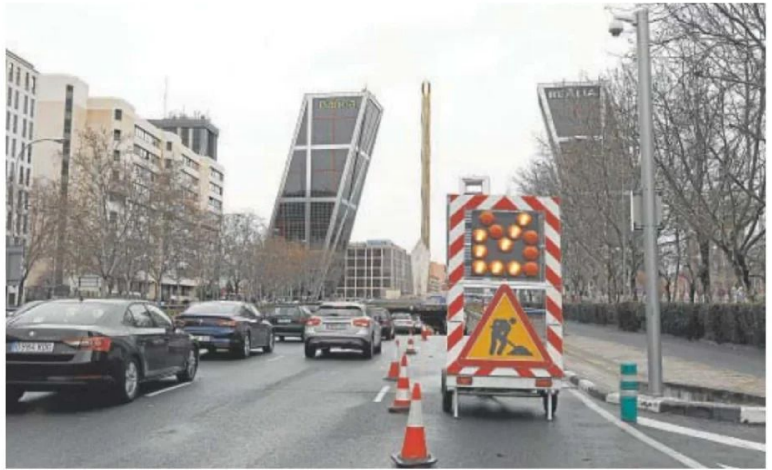
Uno de los accesos al túnel de la plaza de Castilla, en el paseo de la Castellana // ÓSCAR DEL POZO
