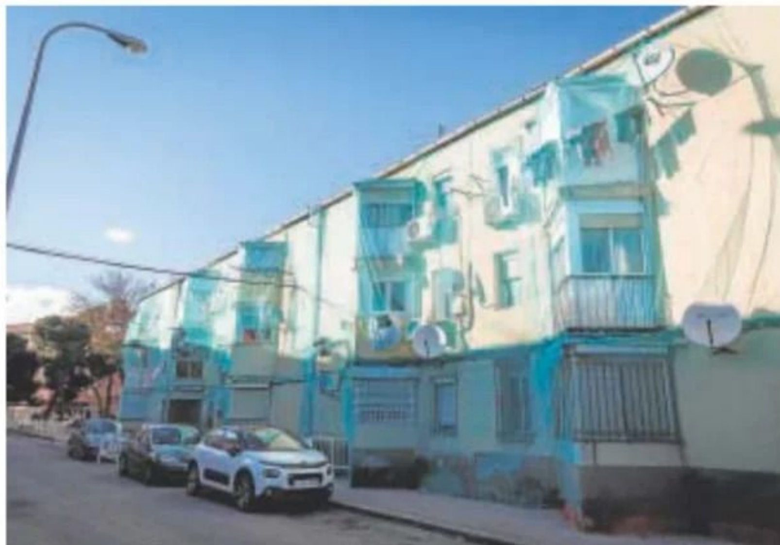
Las mallas en uno de los edificios con orden de ejecución
