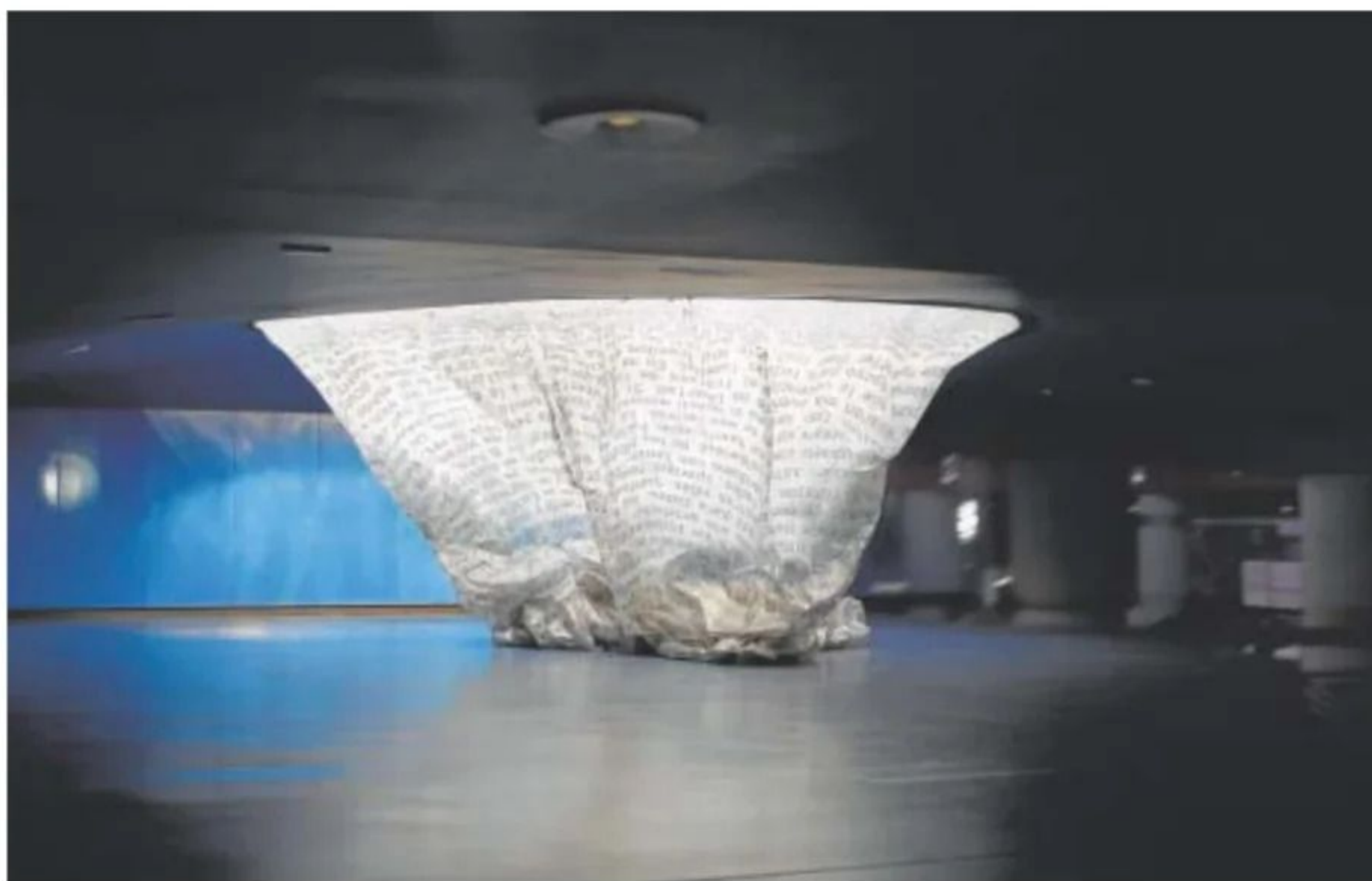
La membrana interna del monumento al 11-M, una de las veces que perdió presión y cayó al suelo // JOSÉ RAMÓN LADRA
