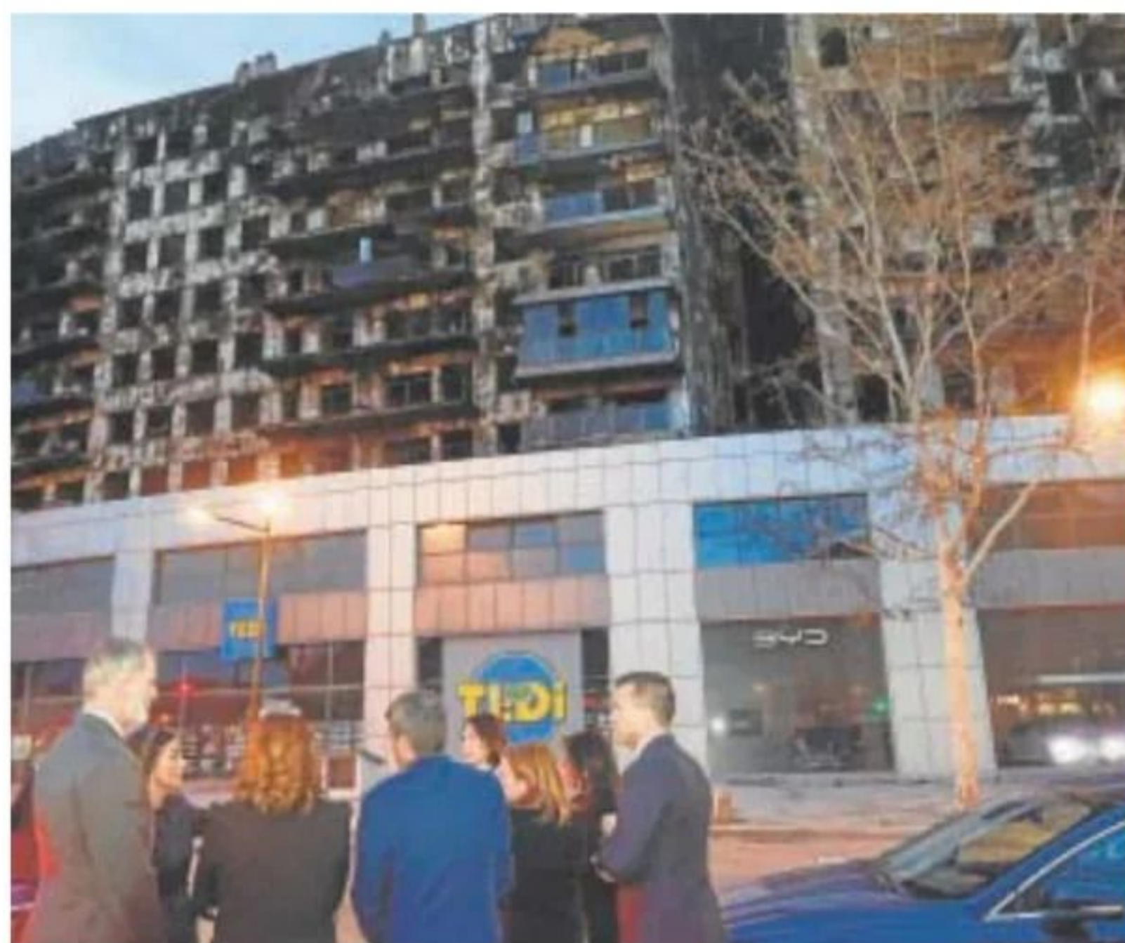
Los Reyes, ayer frente al edificio incendiado en Valencia // EFE
