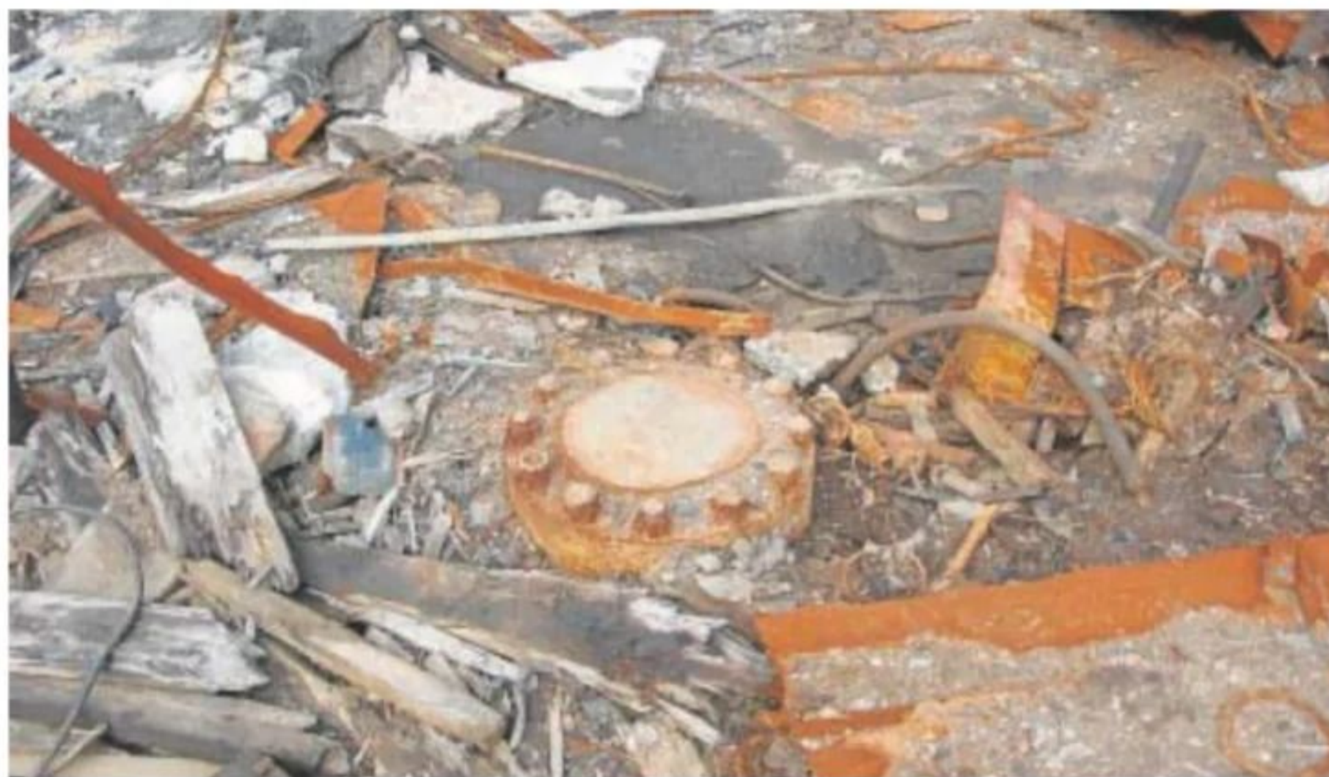
Cubierta del pozo sellado
