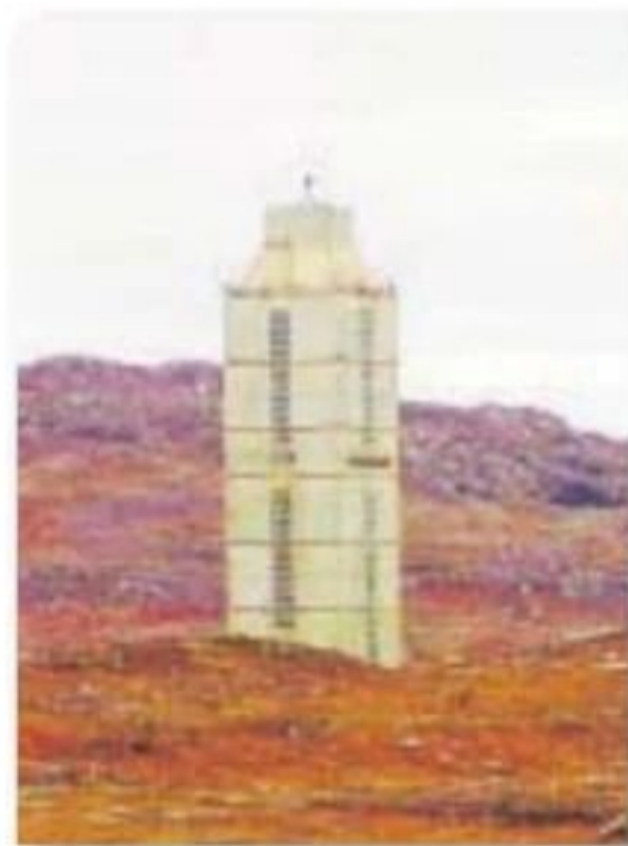
Estructura exterior del pozo
