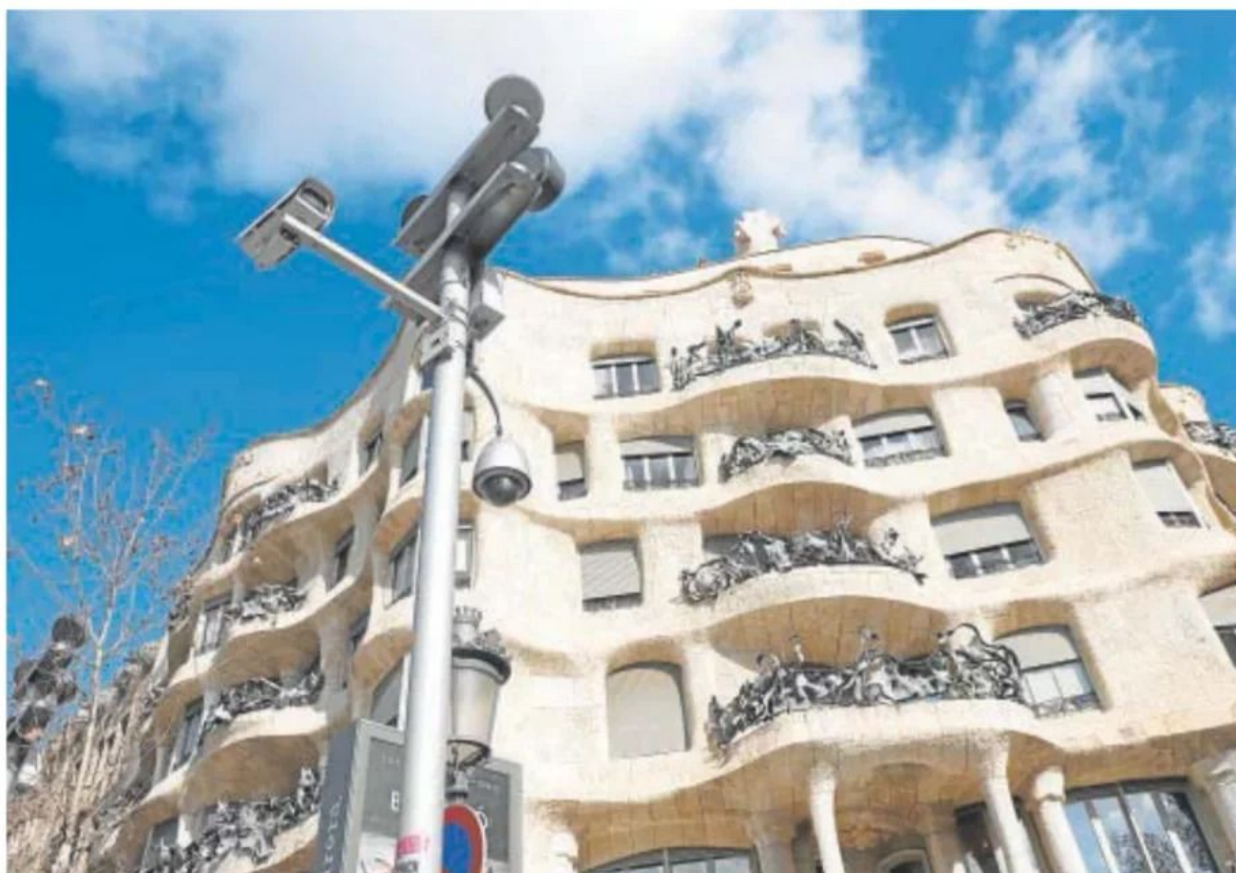
Cámara de seguridad en La Pedrera, Barcelona // INÉS BAUCCELLS
