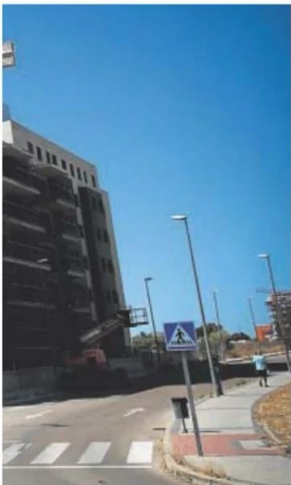
Una promoción de viviendas en construcción // JAIME GARCÍA
