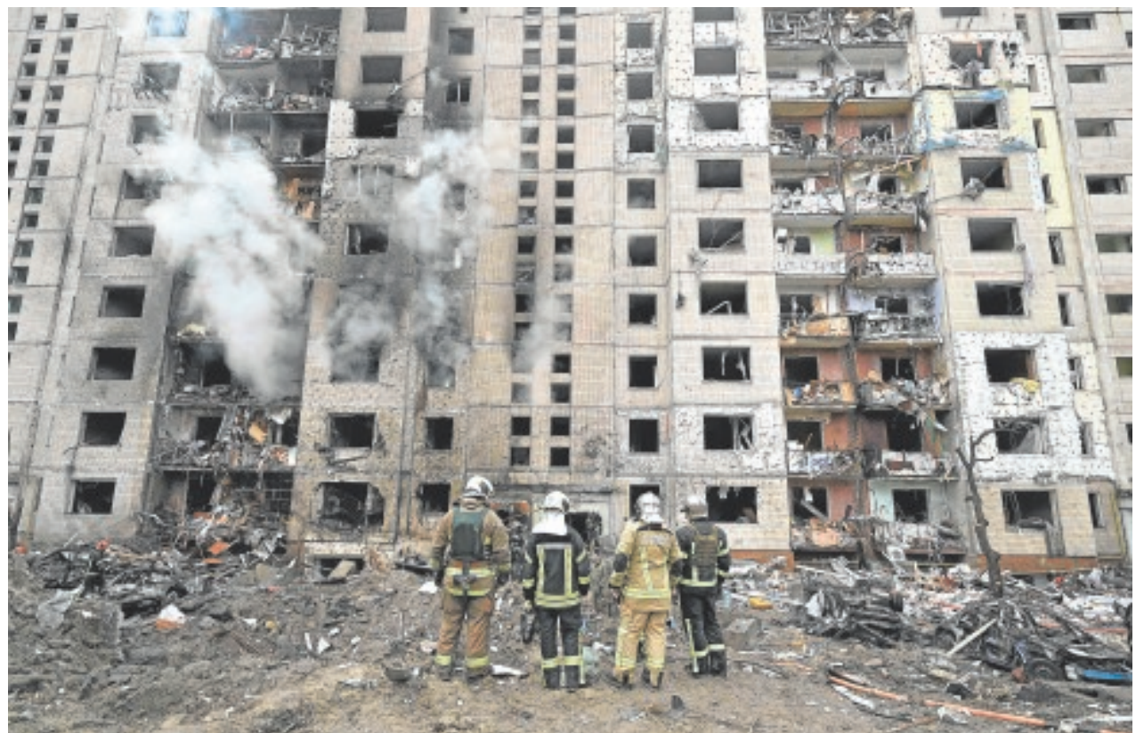
Los servicios de emergencia trabajan en un edificio residencial destruido por misiles en el centro de Kiev // AFP
